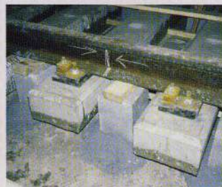
지하철 하부 기초
