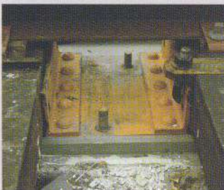
철도 레일 하부 기초
